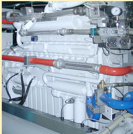
Gasmotor des Blockheizkraftwerks im Klärwerk Möhringen
