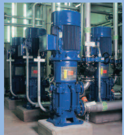
Pumpen zur Betriebswasserversorgung im Sandfiltergebäude.
