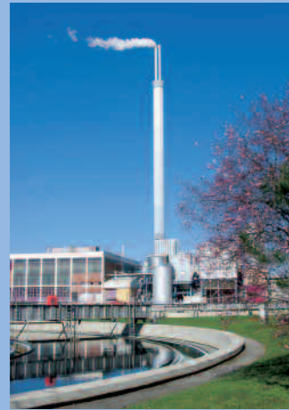
Blick auf die Schlammverbrennung im Hauptklärwerk Mühlhausen, im Vordergrund Nachklärbecken.
