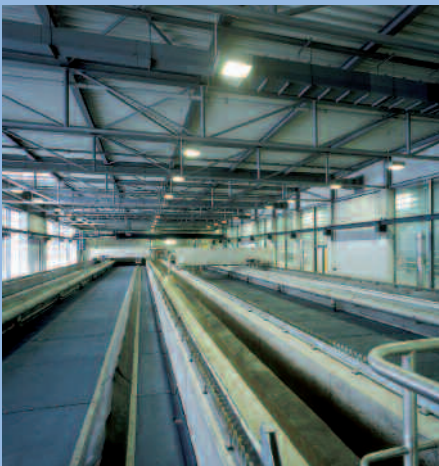
Rechen- und Sandfanganlage Mühlhausen.
