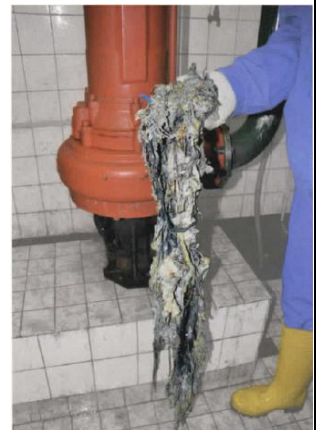
Verzopfte Feuchttücher (Quelle: DWA-Flyer "Vorsicht Pumpenkiller - Problem Feuchttücher")
