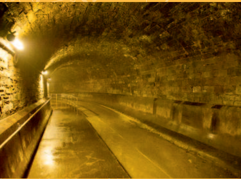
Der Nesenbachkanal gehört mit einem Durchmesser von 5,30 Metern zu den größten Kanälen in Stuttgart.
