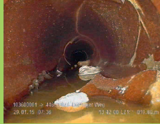
Die Kanalkamera bringt Licht ins Dunkel: Die Kanaldecke ist eingebrochen – eine grundlegende Sanierung steht an.
