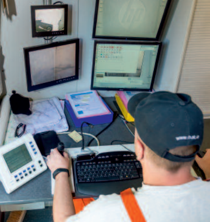
Routineinspektion im Überwachungsfahrzeug. Was die Kamera unten im Kanal sieht, wird zeitgleich dokumentiert und ausgewertet.
