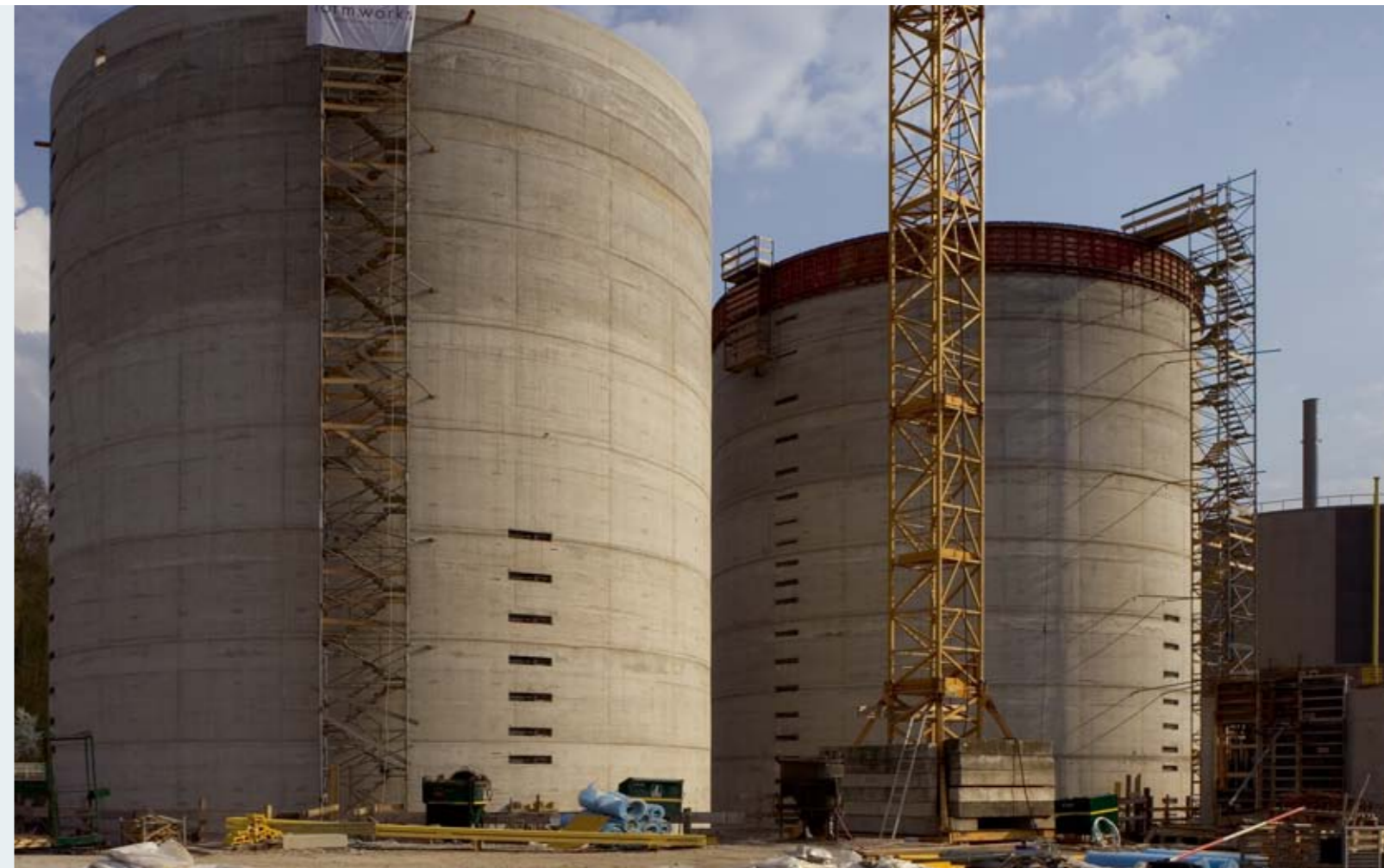
Oben: In Spannbetonbauweise ausgeführt – die mächtigen Behälter der Schlammfäulung im Hauptklärwerk
