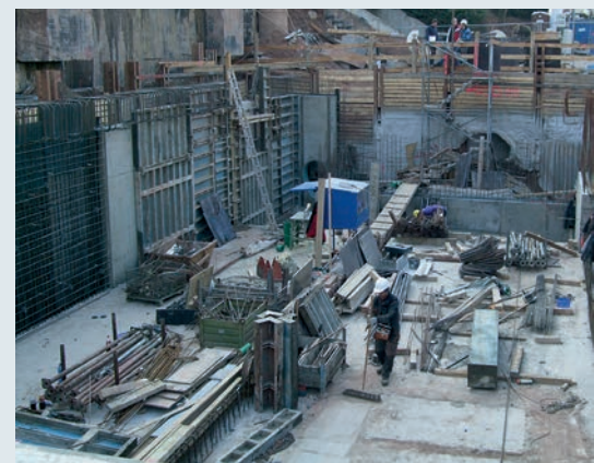
Bauen unter beengten Verhältnissen: Das neue Regenüberlaufbecken in der Tiefenbachstraße ersetzt zukünftig zwei ältere Regenüberläufe
