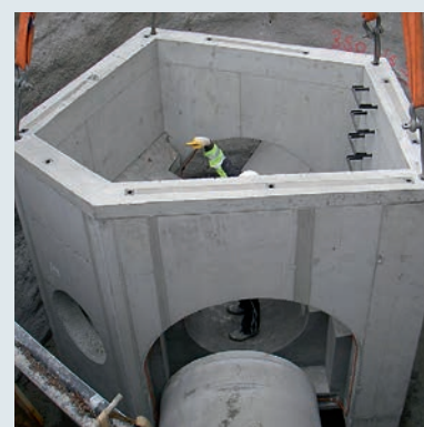
Kanalsanierung Vogelsangstraße: Vorgefertigte Bauteile wie dieser Kanalschacht ermöglichen erheblich verkürzte Bauzeiten
