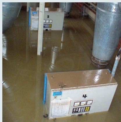
Ungewohnte Technik: die Schaltschränke der Gebläsestation unter Wasser
