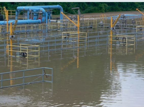
Ungewohnte Ansicht: von den Belebungsbecken sind nur noch Geländer und Belüftungsrohrleitungen zu sehen
