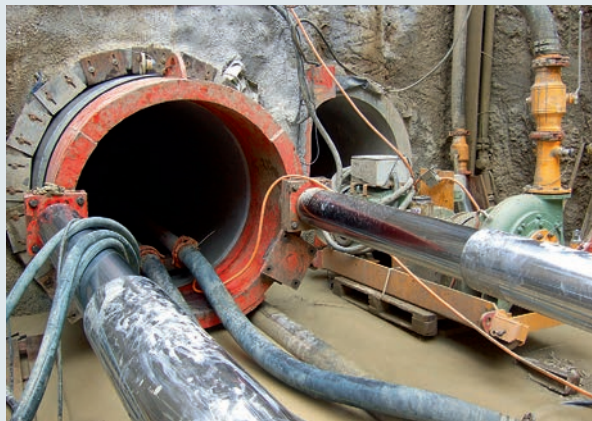
Mit Zwillingstvortrieb und DN 1400 SB-Rohren durch die vorhandene Infrastruktur gezielt: Kanalerneuerung Krefelder Straße
