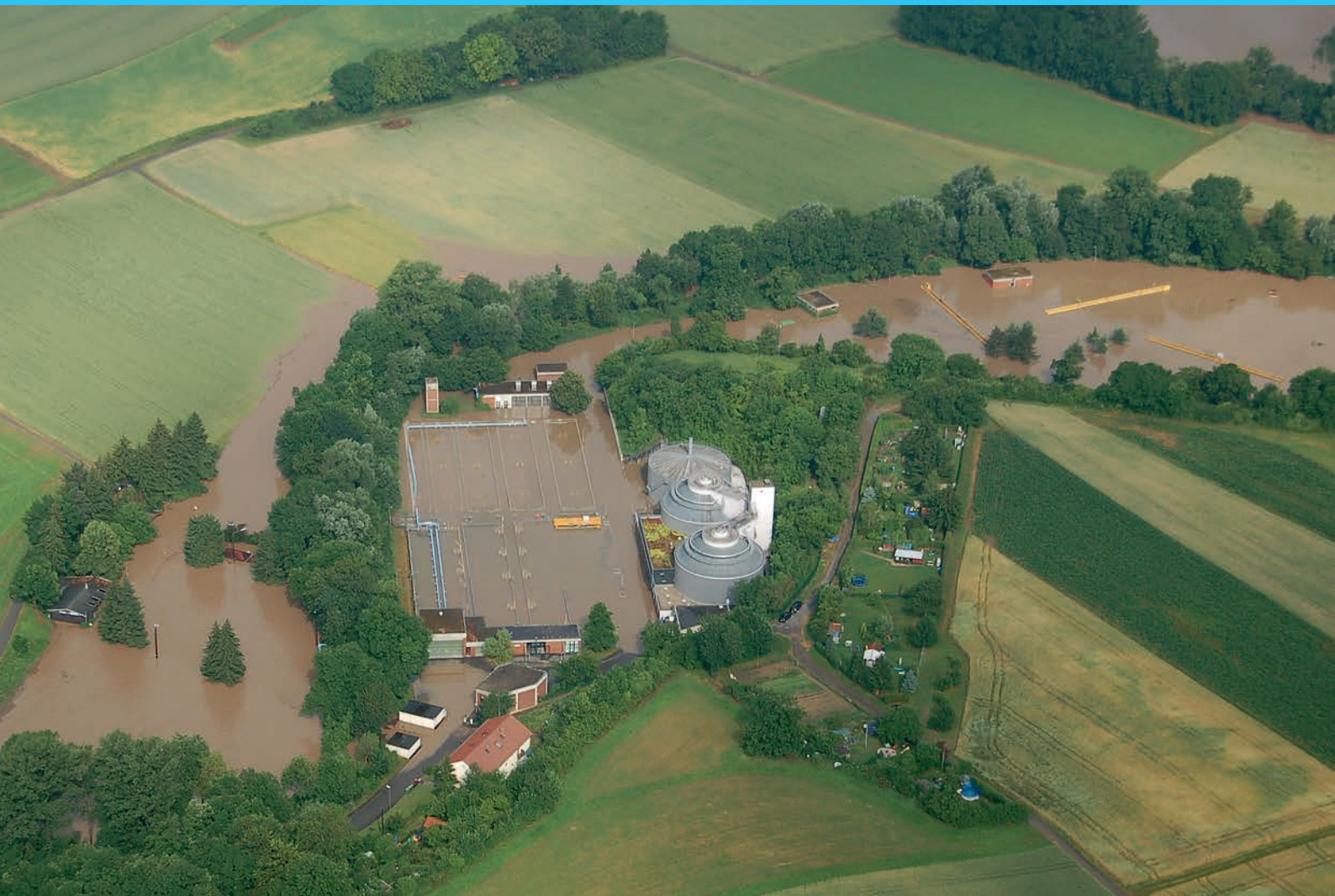
Das Gruppenklärwerk Ditzingen nach dem verheerenden Unwetter vom 4. Juli 2010. Niederschläge von 117 Liter pro Quadratmeter im Einzugsgebiet waren deutlich zu viel für die kleine Glems und führten zur Überflutung des Klärwerks.
