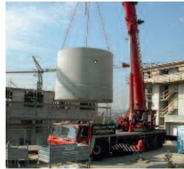
Anlieferung einer Zisterne zur Regenwasserspeicherung
