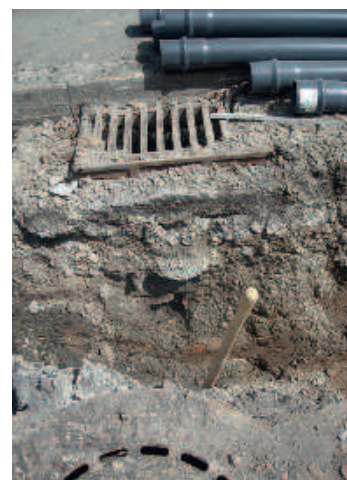
Störfall im Bereich eines Straßeneinlaufs
