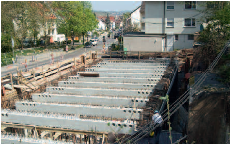
Bau eines neuen Regenüberlaufbeckens an der Tiefenbachstraße
