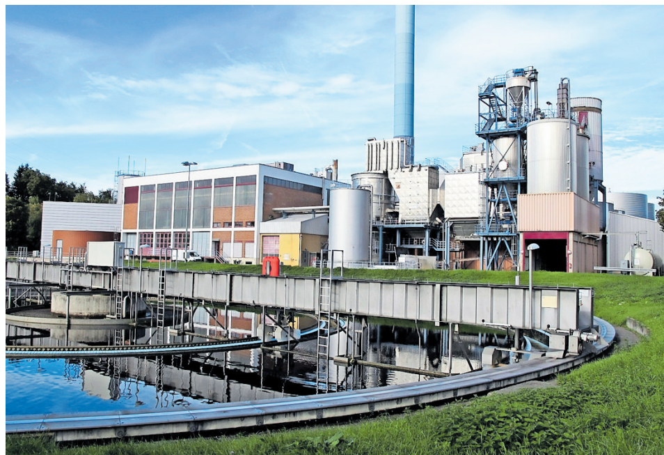
Im Hauptklärwerk in Mühlhausen werden täglich bis zu 160 Millionen Liter Abwasser gereinigt. Foto: SES
