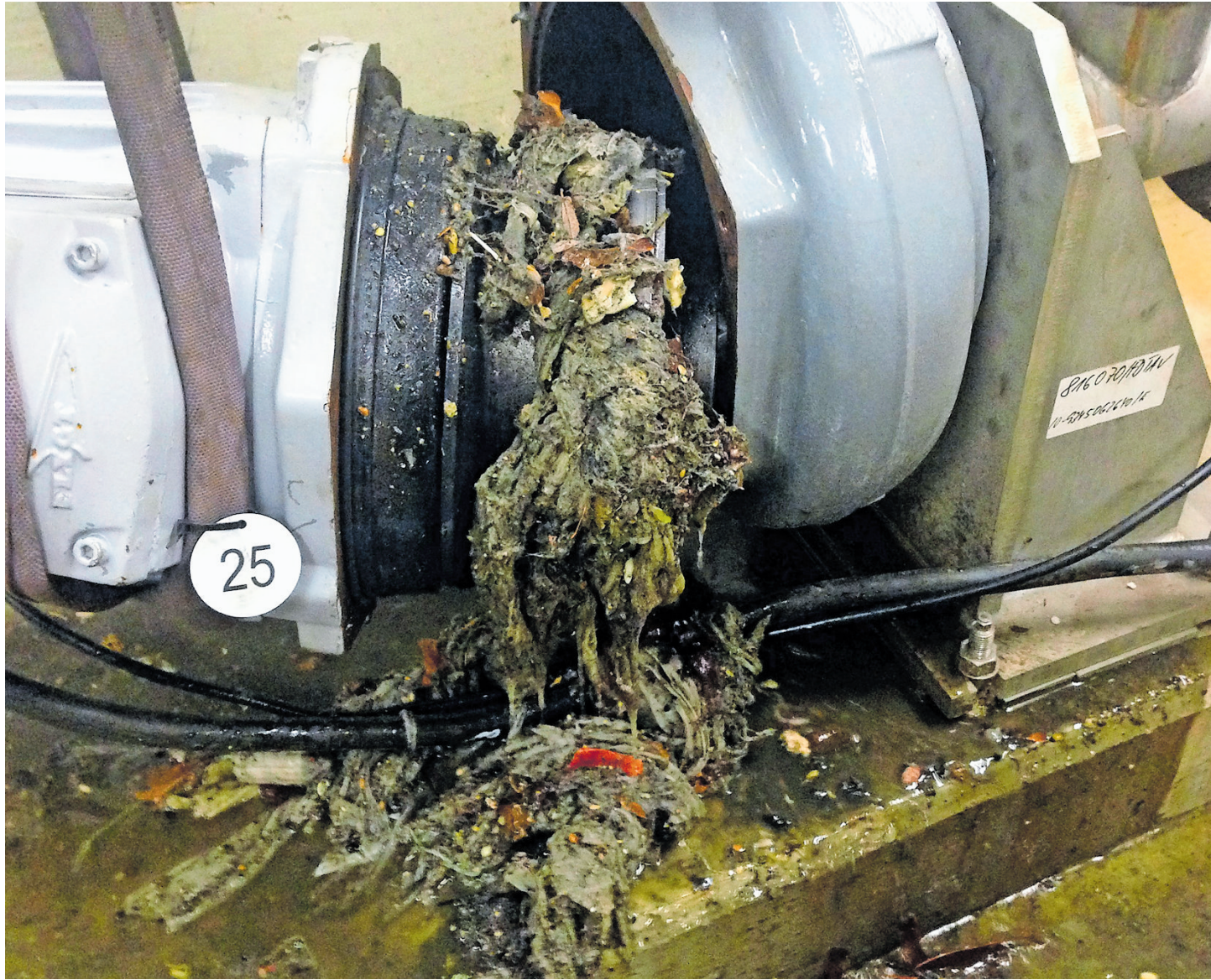
Feuchte Tücher sammeln sich an den Pumpen im Klärwerk sowie im Kanalsystem und stören so den Betriebsablauf. Foto: SES
