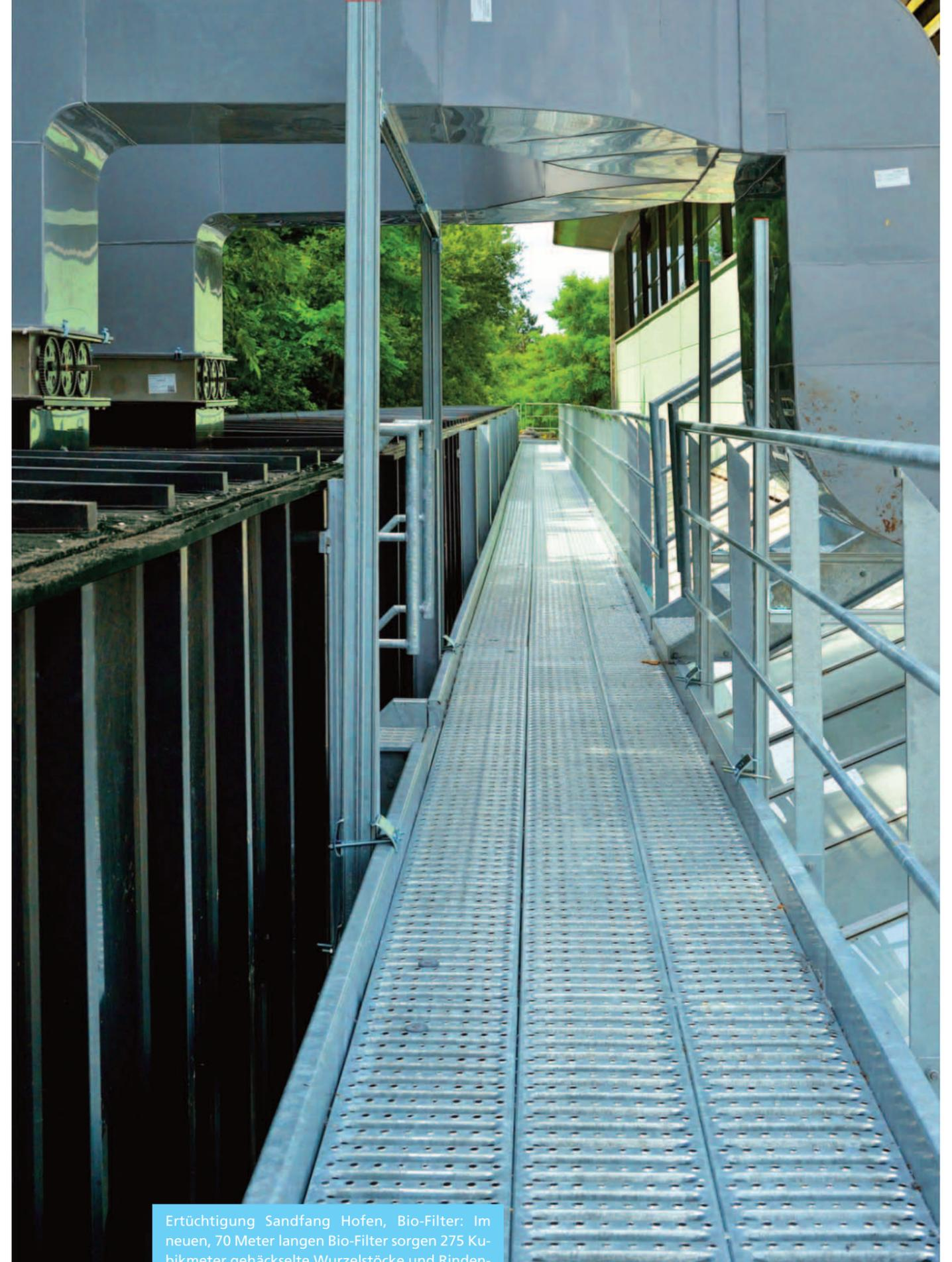
Ertüchtigung Sandfang Hofen, Bio-Filter: Im neuen, 70 Meter langen Bio-Filter sorgen 275 Kubikmeter gehäckselte Wurzelstöcke und Rindenmulch dafür, dass nichts mehr riecht. 24 000 Kubikmeter Abluft pro Stunde werden mit einem Wirkungsgrad von 99 Prozent gefiltert.
