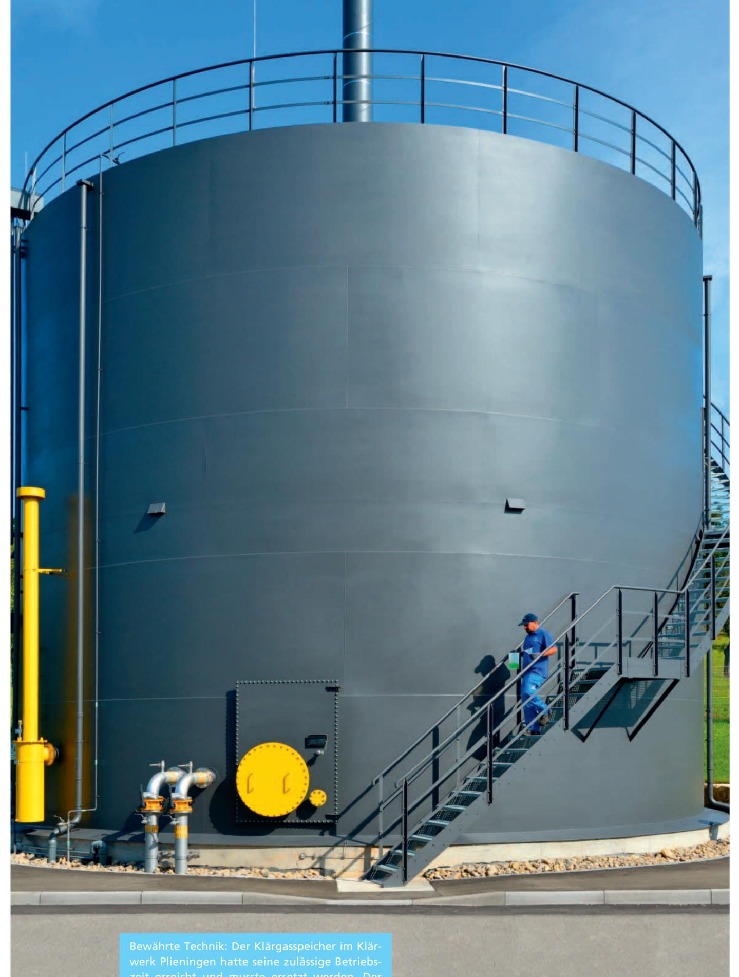
Bewährte Technik: Der Klärgasspeicher im Klärwerk Plieningen hatte seine zulässige Betriebszeit erreicht und musste ersetzt werden. Der neue Gasspeicher besitzt ein Fassungsvermögen von 1000 Kubikmetern, die Speichertechnik ist jetzt in allen Stuttgarter Klärwerken in Betrieb.
