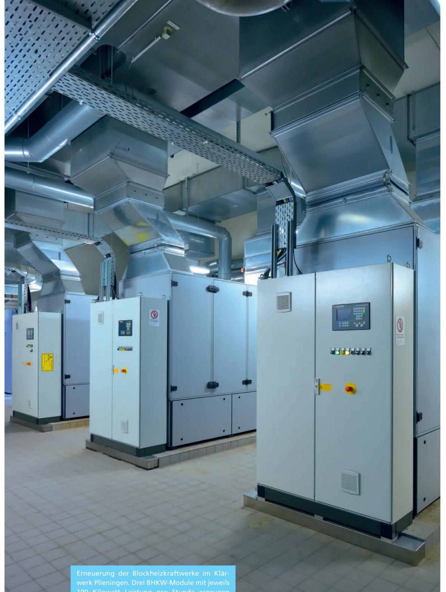
Erneuerung der Blockheizkraftwerke im Klärwerk Plieningen. Drei BHKW-Module mit jeweils 100 Kilowatt Leistung pro Stunde erzeugen Strom und Wärme für das Klärwerk. Die neuen Module haben einen deutlich höheren Wirkungsgrad und sind wartungsärmer.
