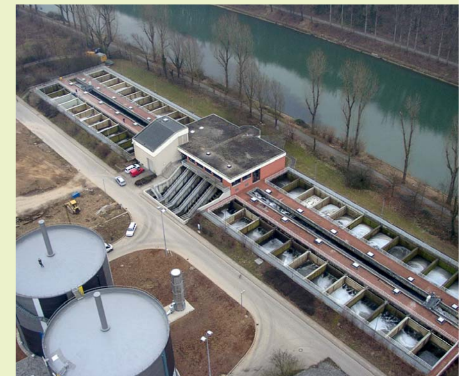
Wenige Klärwerke in Europa verfügen über eine eigene Sandfilteranlage.
