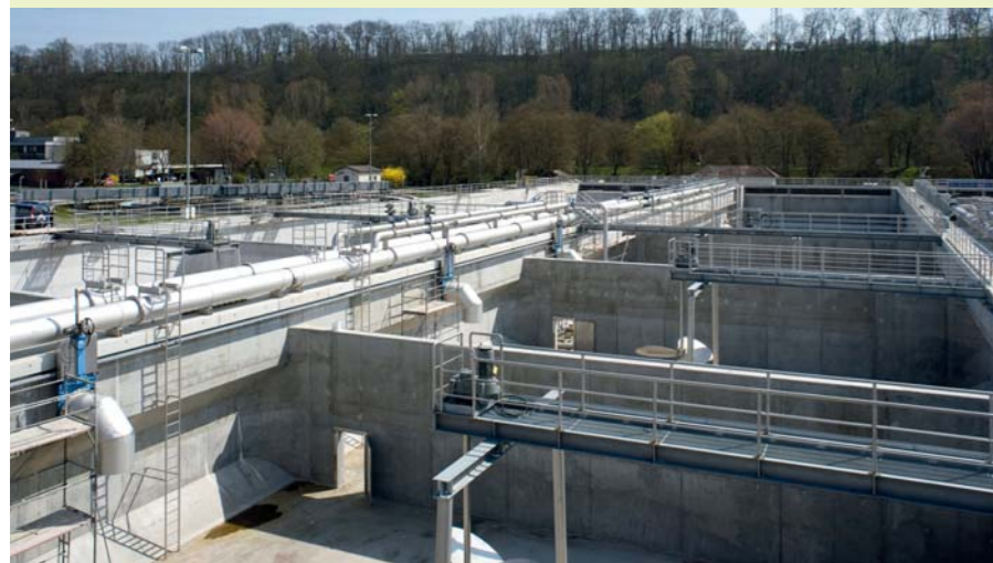
Drei neue Belebungsbecken wurden im Hauptklärwerk gebaut.
