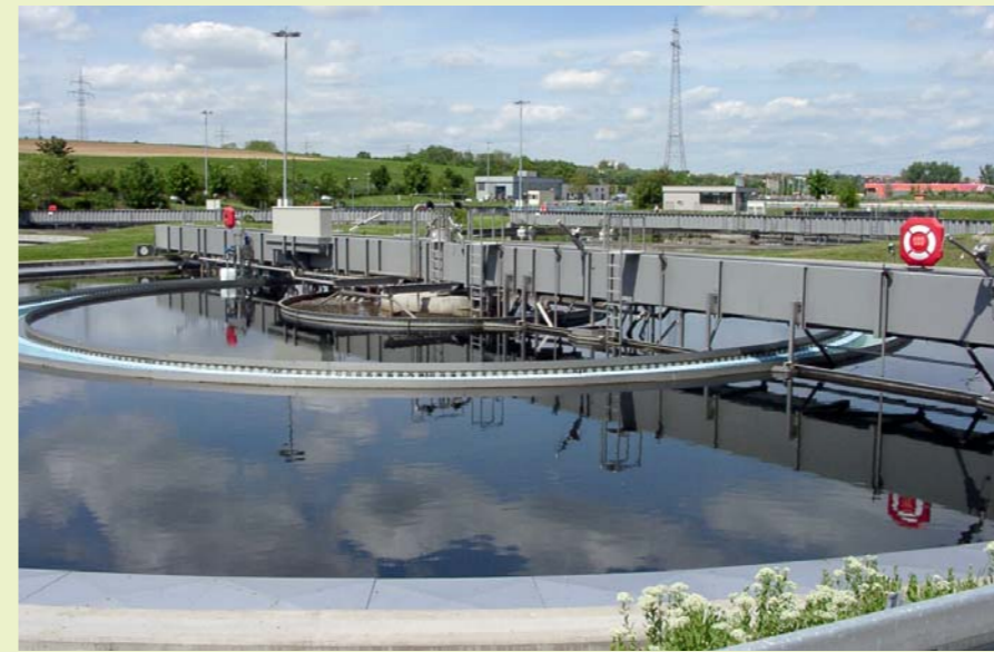
In den Nachklärbecken setzen sich Mikroorganismen als Belebtschlamm ab.
