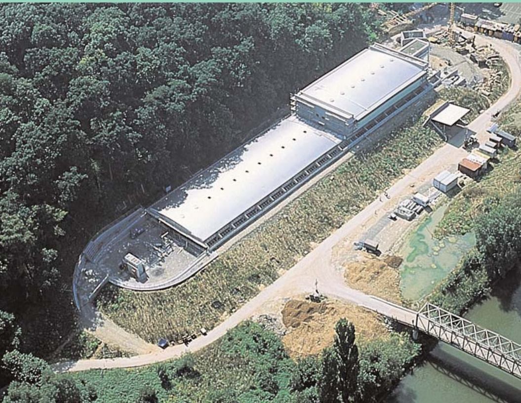
Blick auf die Gesamtanlage
