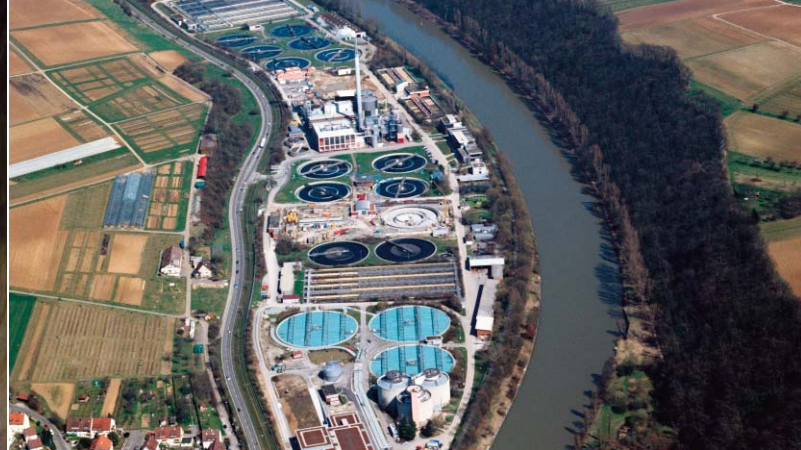
Das Hauptklärwerk Mühlhausen öffnet für Besucher.
