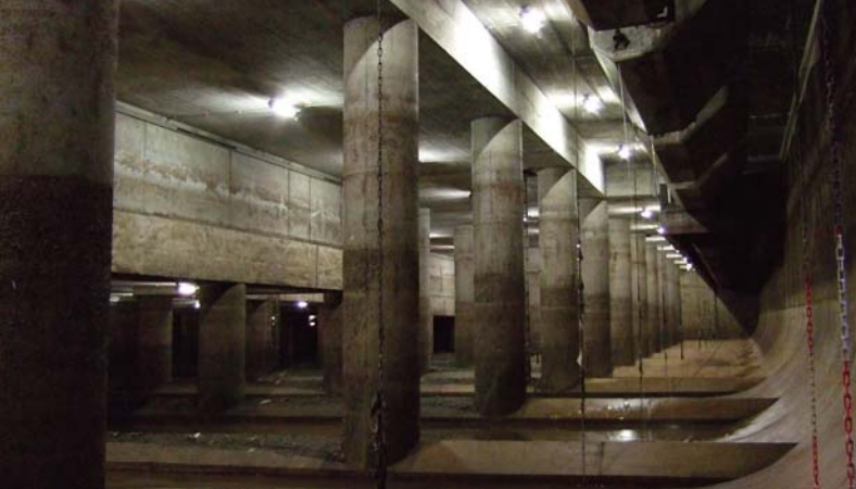
Das Regenüberlaufbecken am Schwanenplatz schützt den Neckar.
