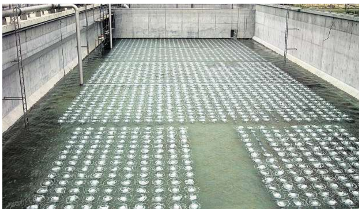
Eine Sprudelprobe in einem der drei neuen Belebungsbecken mit „Dombelüftern“: Feinporige Keramikscheiben, die Sauerstoff als Bläschen im Abwasser verteilen (oben). Im Pumpenhaus (rechts) wird das biologisch gereinigte Abwasser in den Rohwasserverteilerkanal gehoben. FOTOS: SES
