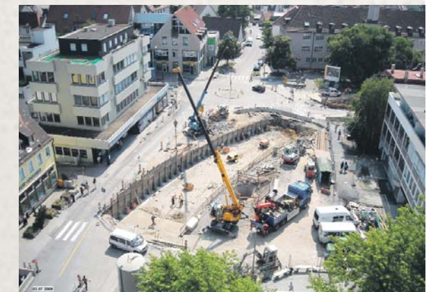
Die Baugrube der U15-Trasse kann von Besuchern ohne Höhenangst besichtigt werden.
