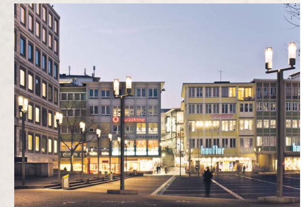
Um die neue LED-Straßenbeleuchtung geht es am Infostand 3.
