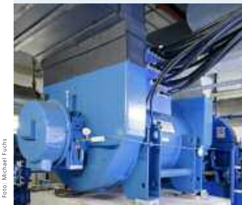
Dampfturbine im Hauptklärwerk Mühlhausen
