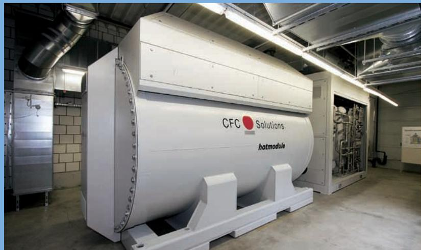
Die Hochtemperatur-Brennstoffzelle im Klärwerk Möhringen
