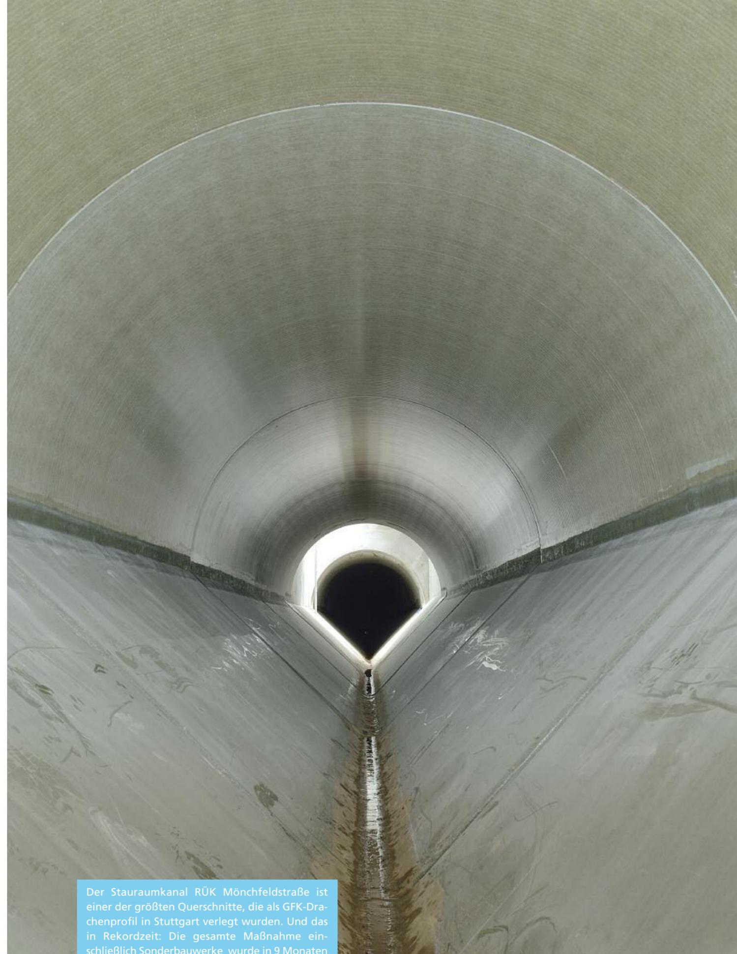
Der Stauraumkanal RÜK Mönchfeldstraße ist einer der größten Querschnitte, die als GFK-Dra-chenprofil in Stuttgart verlegt wurden. Und das in Rekordzeit: Die gesamte Maßnahme einschließlich Sonderbauwerke wurde in 9 Monaten abgeschlossen.
