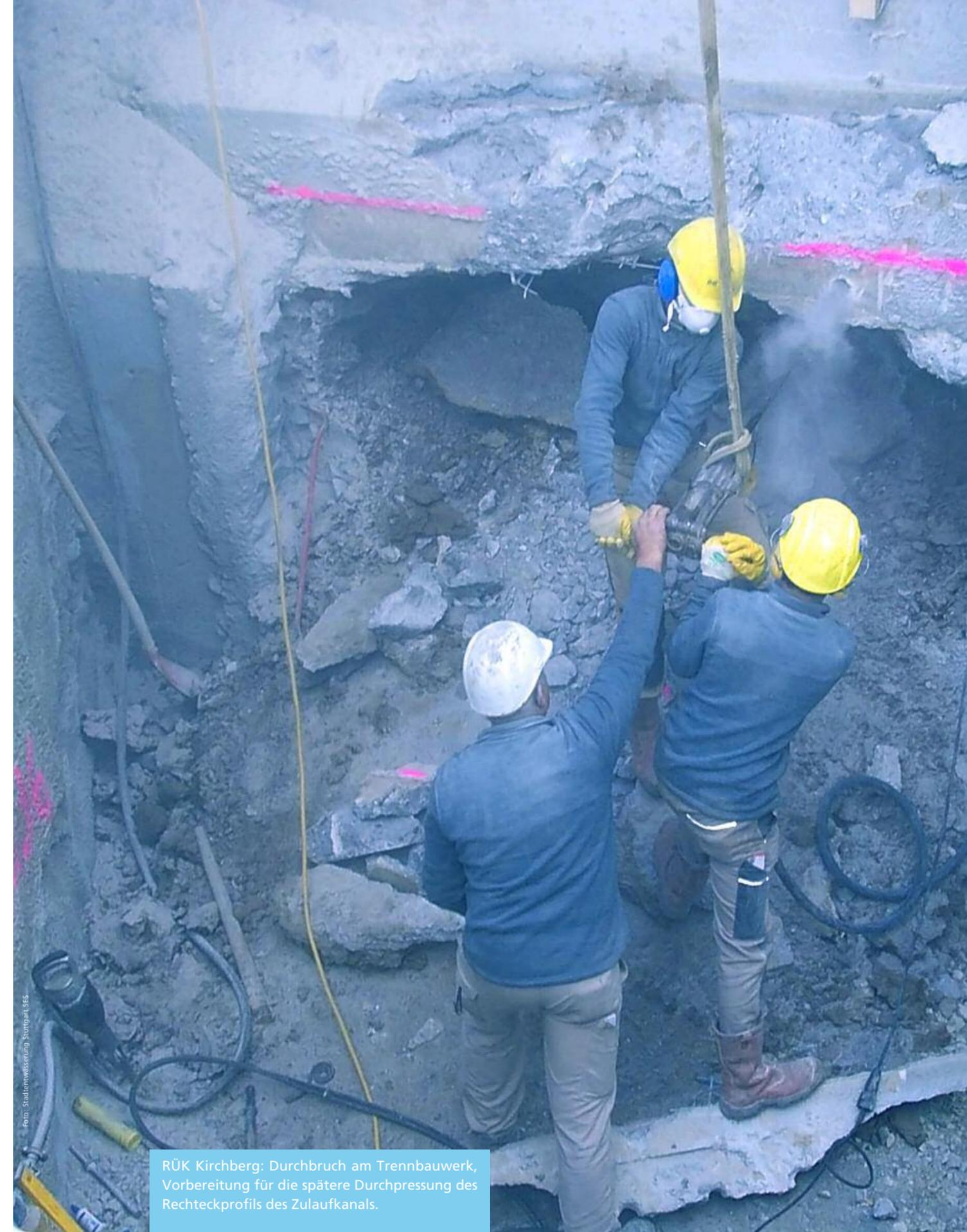
RÜK Kirchberg: Durchbruch am Trennbauwerk, Vorbereitung für die spätere Durchpressung des Rechteckprofils des Zulaufkanals.
