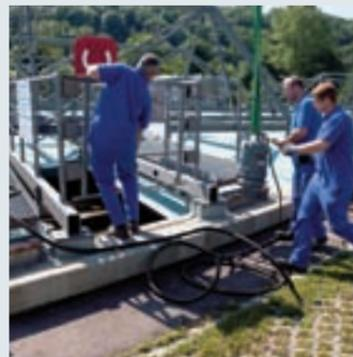
Störfallbehebung: Das Team der Vorklärung wechselt routiniert eine defekte Pumpe aus
