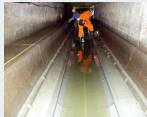
Wärmetauschelemente für die Abwasserwärmenutzung im Kanal unterhalb der Daimlerstraße
