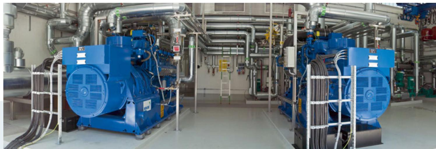
Das neue Blockheizkraftwerk im Hauptklärwerk Mühlhausen besteht aus zwei Modulen
