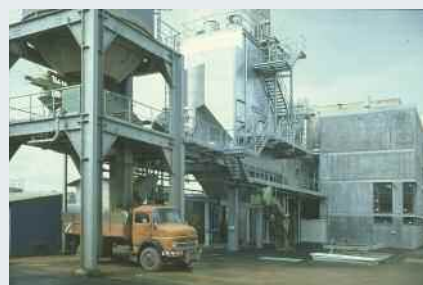
Die Schlammverbrennung 1982 mit dem neuen Wirbelschichtofen II und der Rauchgasfilteranlage
