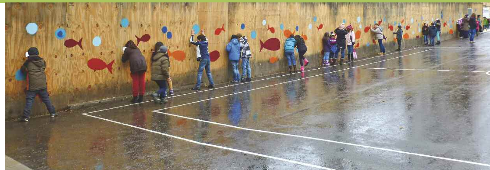
Kinder der Bachschule bei der täglichen Bauüberwachung: Während der Bauzeit des Regenüberlaufbeckens Bachschule mussten die Kinder auf ihren Spielplatz verzichten
