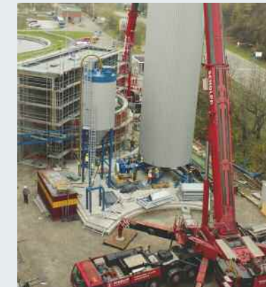
3D-Modell der 2. Klärschlammannahmestation und Aufstellen des 50 Tonnen schweren Silos
