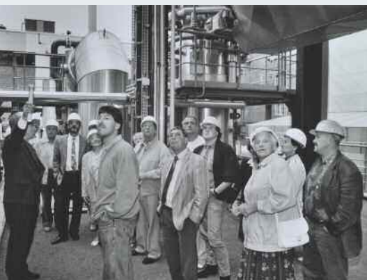
1993: Mitglieder der Schutzgemeinschaft Mühlhausen besichtigen die neue Klärschlammverbrennungsanlage im Hauptklärwerk Mühlhausen (Bild M. Steinert, STZ)
