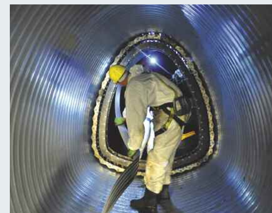
Zwei Beispiele für innovative Sanierungsverfahren: Das Wickelrohrverfahren...
