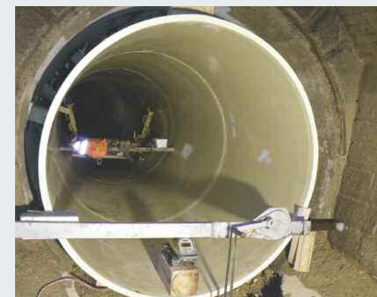
... und das Kurzrohr-Relining
