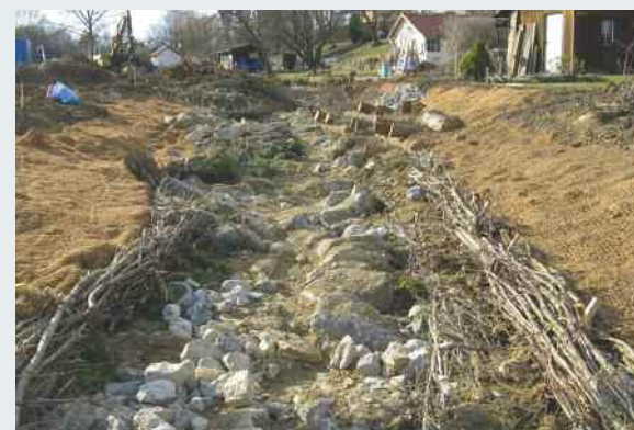
Die Renaturierung des Tränkebachs: Gut erkennbar sind das flach ausgestaltete Ufer und der Uferverbau
