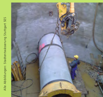
Rohrvortrieb für den Zulaufkanal zum neuen RÜB Paracelusstraße in Stuttgart-Plieningen
