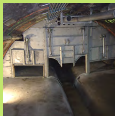
Regenüberlaufkanal Borsigstraße: eine von vier Kaskadenstauwänden nach dem Einbau
