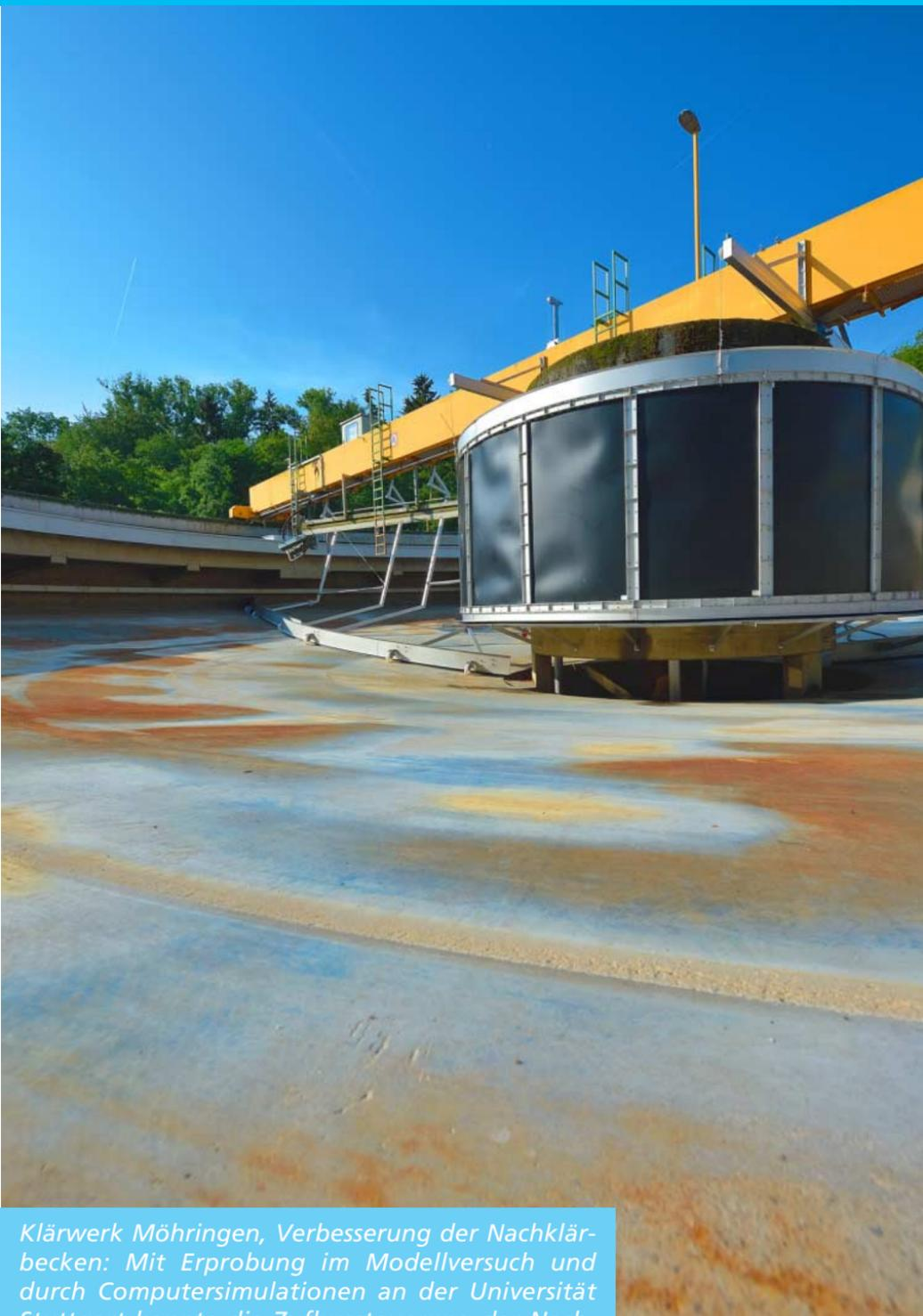
*Klärwerk Möhringen, Verbesserung der Nachklärbecken: Mit Erprobung im Modellversuch und durch Computersimulationen an der Universität Stuttgart konnte die Zuflusssteuerung der Nachklärbecken verbessert werden – die Ablaufwerte ebenfalls.*
