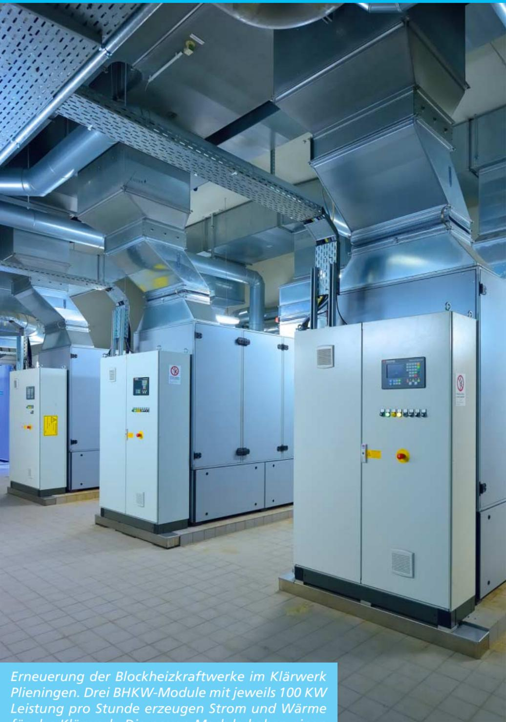
*Erneuerung der Blockheizkraftwerke im Klärwerk Plieningen. Drei BHKW-Module mit jeweils 100 KW Leistung pro Stunde erzeugen Strom und Wärme für das Klärwerk. Die neuen Module haben einen deutlich höheren Wirkungsgrad und sind wartungsärmer.*
