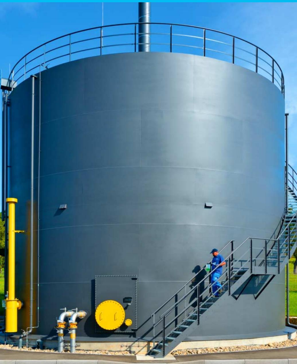
*Bewährte Technik: Der Klärgasspeicher im Klärwerk Plieningen hatte seine zulässige Betriebszeit erreicht und musste ersetzt werden. Der neue Gasspeicher besitzt ein Fassungsvermögen von 1 000 Kubikmetern, die Speichertechnik ist jetzt in allen Stuttgarter Klärwerken in Betrieb.*
