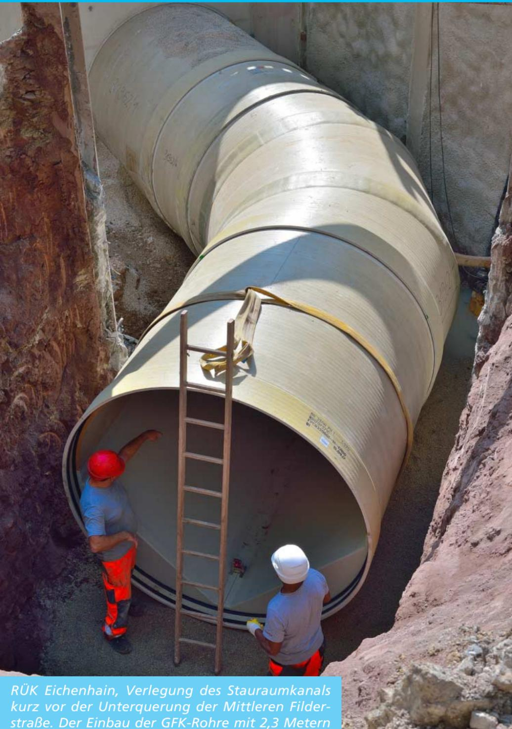
RÜK Eichenhain, Verlegung des Stauraumkanals kurz vor der Unterquerung der Mittleren Filderstraße. Der Einbau der GFK-Rohre mit 2,3 Metern Durchmesser erfolgte in offener Bauweise an nur einem Wochenende.
