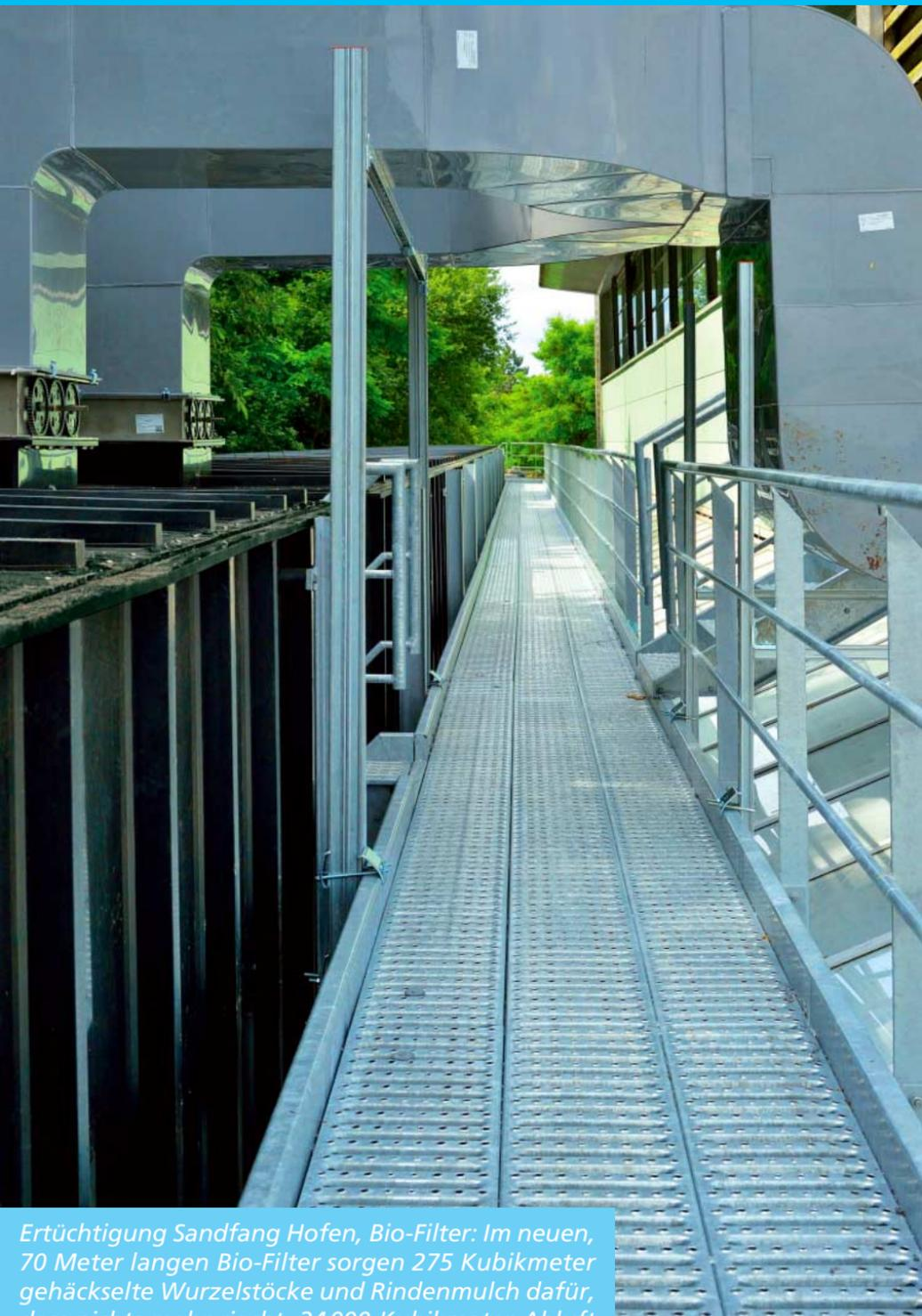
*Ertüchtigung Sandfang Hofen, Bio-Filter: Im neuen, 70 Meter langen Bio-Filter sorgen 275 Kubikmeter gehäckselte Wurzelstöcke und Rindenmulch dafür, dass nichts mehr riecht. 24000 Kubikmeter Abluft pro Stunde werden mit einem Wirkungsgrad von 99 Prozent gefiltert.*
