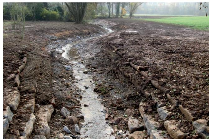
Im Zuge der Renaturierungsmaßnahmen wurde der Ramsbach in sein ursprüngliches Bachbett zurückgeführt und die natürliche Überflutungsfläche wieder hergestellt bzw. weiter ausgebaut.
