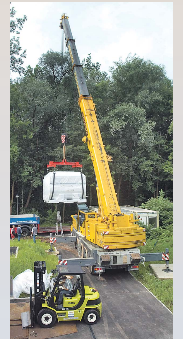
Das Klärwerk verfügt über eine Klärgasbetriebene Brennstoffzelle, hier beim Einbau, die eigenen Strom erzeugt.
