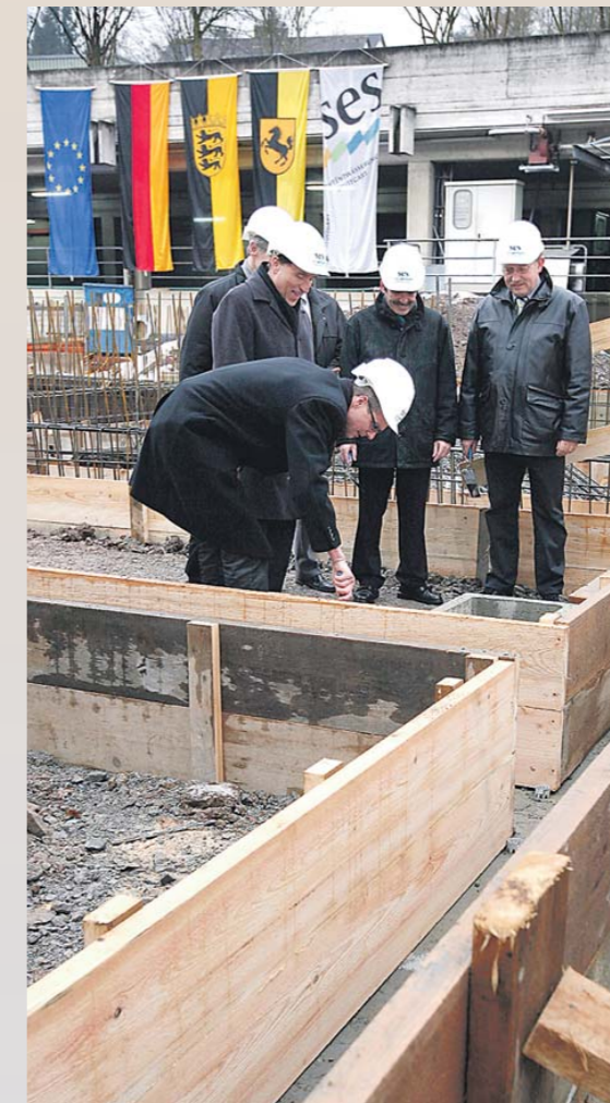
Der Grundstein für die Schlammmentwässerungsanlage wurde im Dezember 2008 gelegt.
