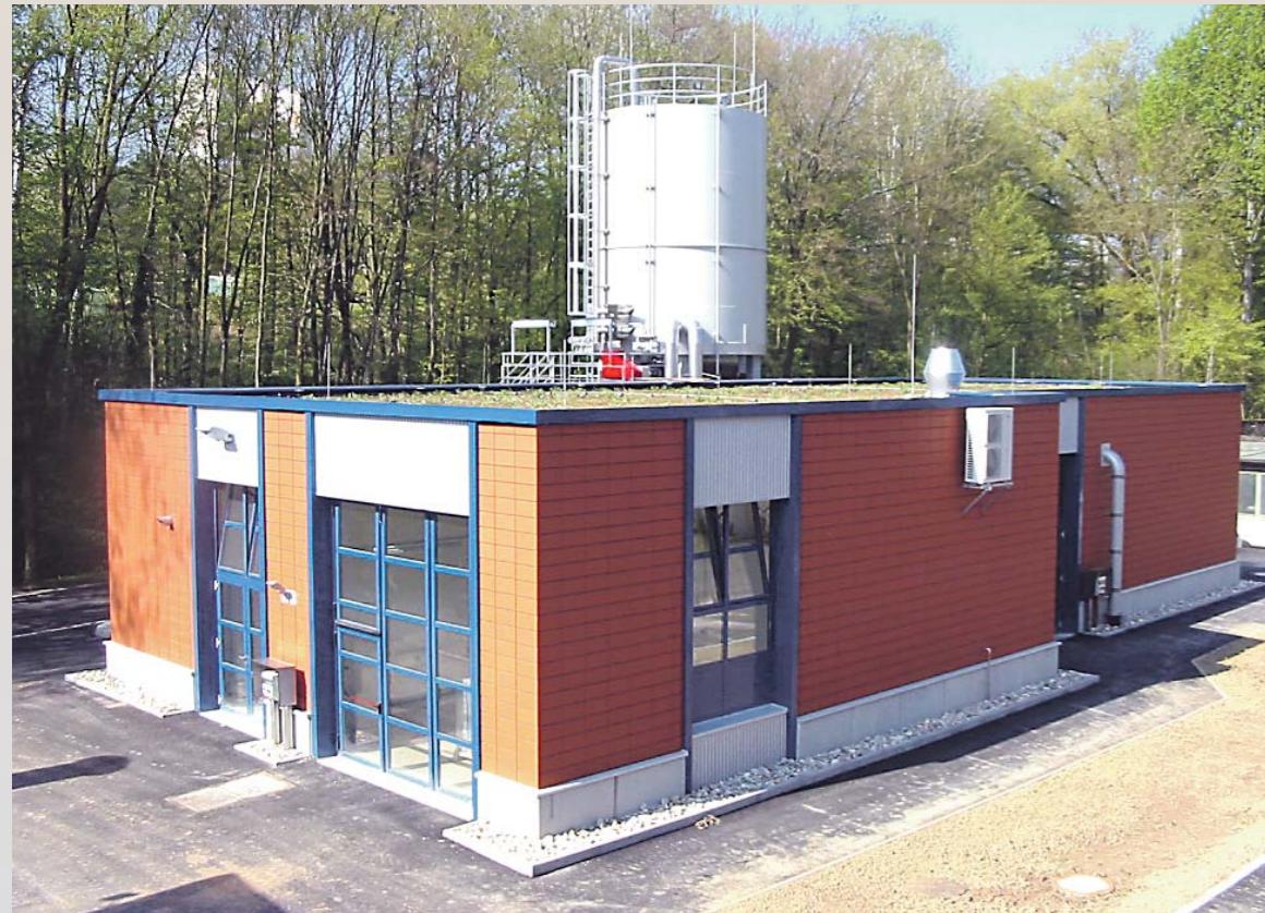
Modernste Technik befindet sich im neuem Schlammmentwässerungsgebäude. Das neue Silo (rechtes Bild) kann 100 Kubikmeter entwässerten Schlamm speichern.
