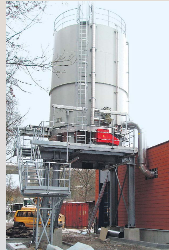
Modernste Technik befindet sich im neuem Schlammmentwässerungsgebäude. Das neue Silo (rechtes Bild) kann 100 Kubikmeter entwässerten Schlamm speichern.
