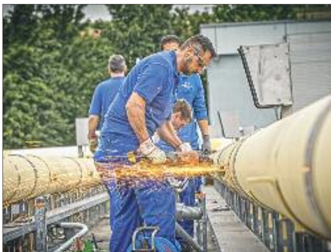
Die Beschäftigten betreiben und warten die weit verzweigten Abflusssysteme, die Abwasserreinigungseinrichtungen und die Schlammbehandlungsanlagen. Foto: Fuchs
