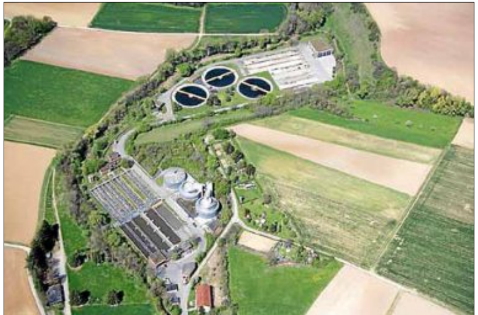
Luftbild Gruppenklärwerk Ditzingen vor Beginn der Erneuerungsmaßnahmen
