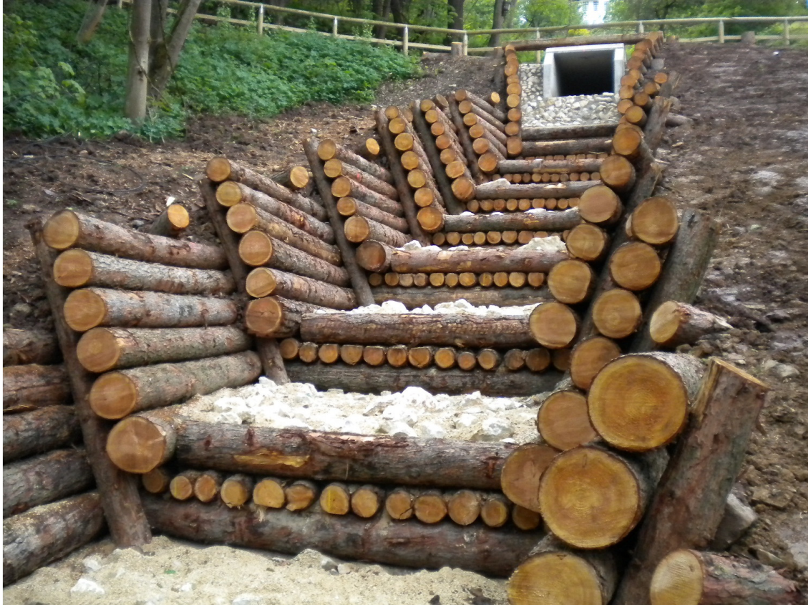
Bild 1: Obere zusammenhängende Holzverbauung
