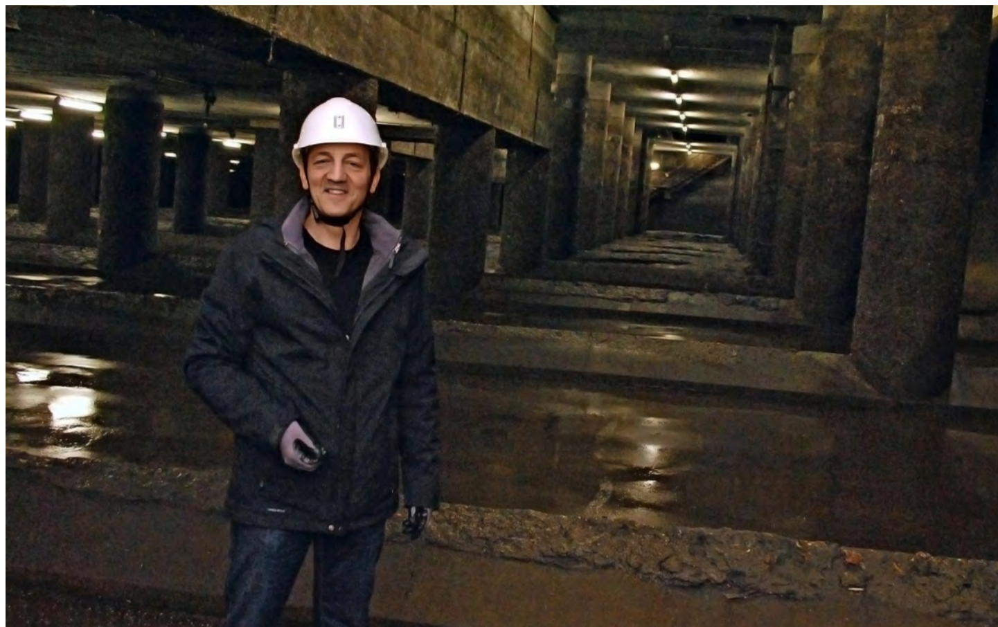
Bei starkem Niederschlag nicht zu empfehlen: Jürgen Sprich mitten im Regenüberlaufbecken.
